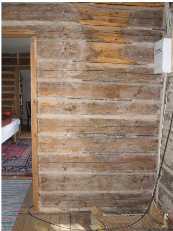
Väggen där prov dju31 & dju32 hämtats
